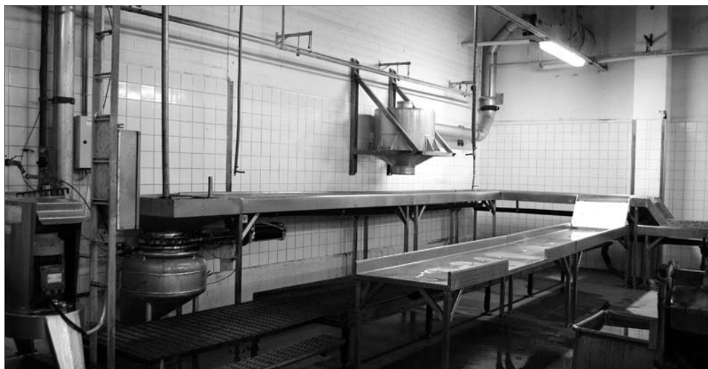
Joonis 50. Sea soolekomplekti vastuvõtmise ja töötlemise liin
