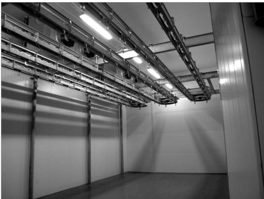
Joonis 5. Jahutuskamber konveier-rippteega
