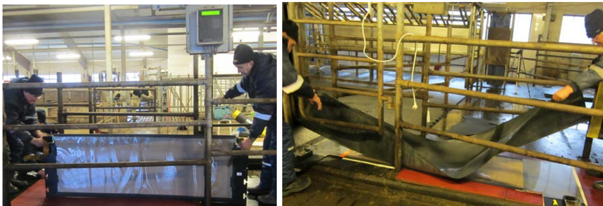
Joonis 5. Kõnnistendi montaaž alusele: vasakul jalasurve maatriksmati, paremal katete paigaldamine
