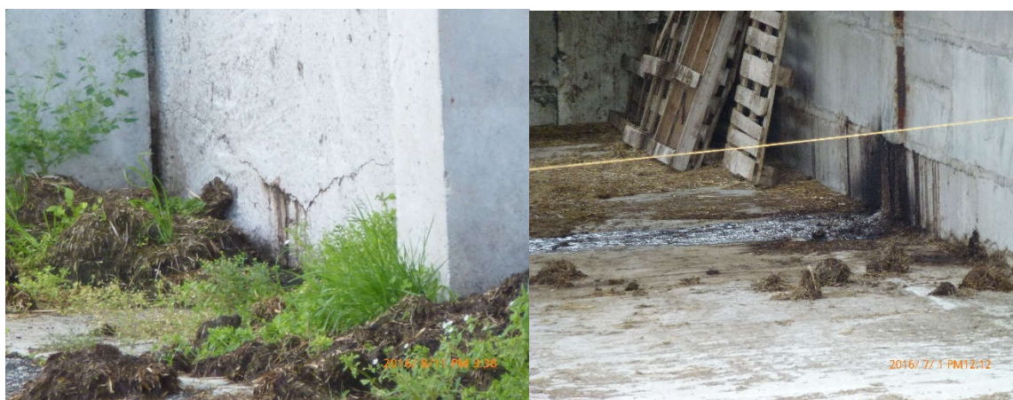
Joonis 5.12. Tahesõnnikuhoidla leke
